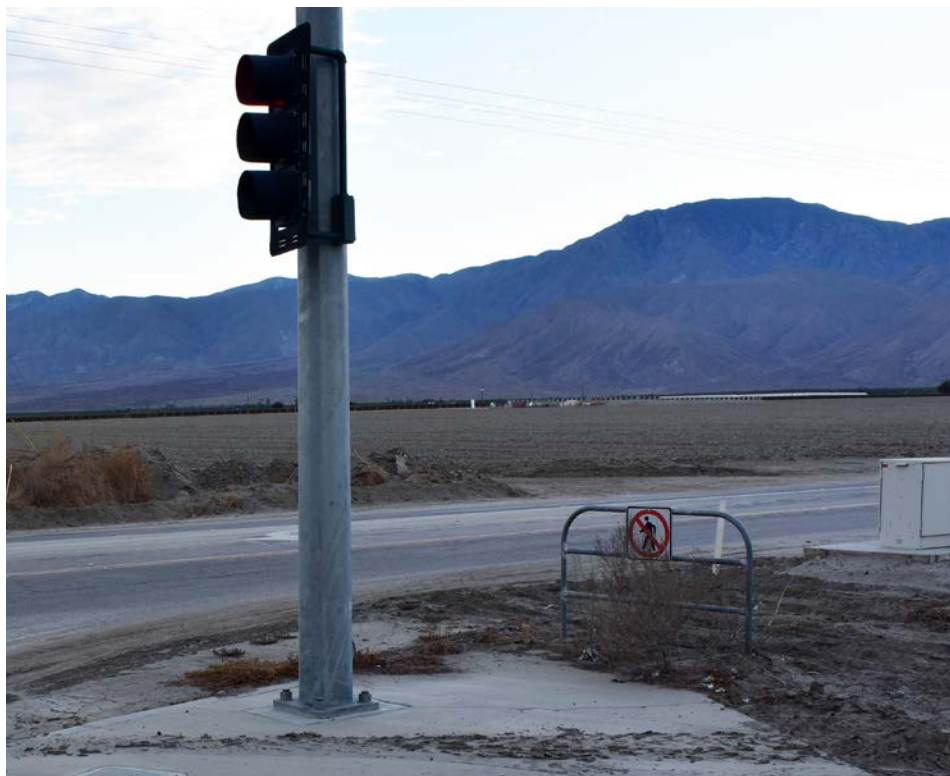
Las intersecciones señalizadas no tienen conexión con otras Instalaciones para peatones
